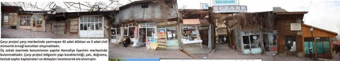
HACI ALİ AKIN CADDESİ MEVCUT GÖRÜNÜŞÜ
