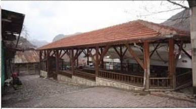
BUĞDAY MEYDANI VE BUĞDAY MEYDANI SOKAK MEVCUT GÖRÜNÜŞÜ
