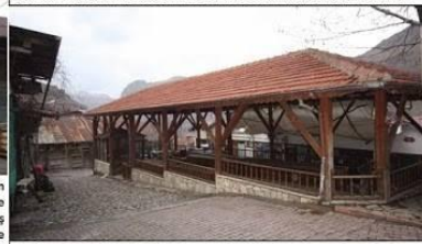
BUĞDAY MEYDANI VE BUĞDAY MEYDANI SOKAK MEVCUT GÖRÜNÜŞÜ
