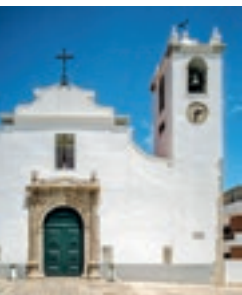
Église paroissiale de Santa Catarina da Fonte do Bispo
